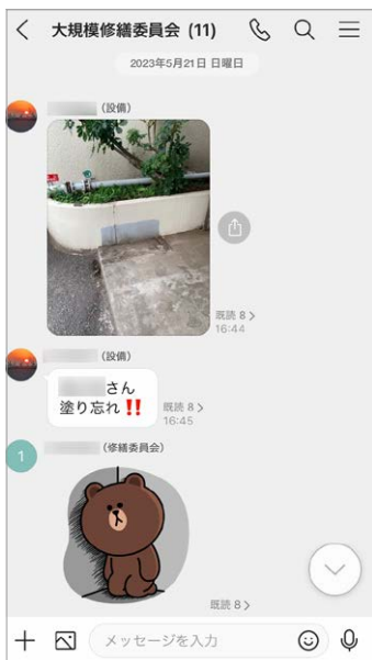
設備の不具合は写真とともに報告
